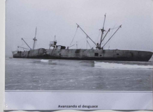
Avanzando el desguace
