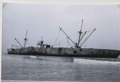
Avanzando el desguace
