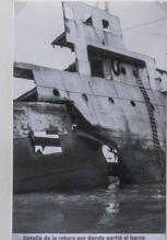
Detalle de la ruptura por donde partió el barco
